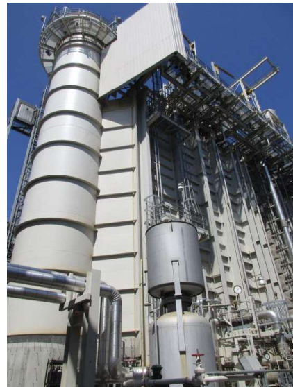
Figure 5-3 — Palomar Step-Up Generator & HRSG
