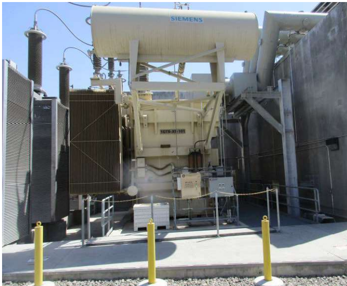
Figure 5-3 — Palomar Step-Up Generator & HRSG
