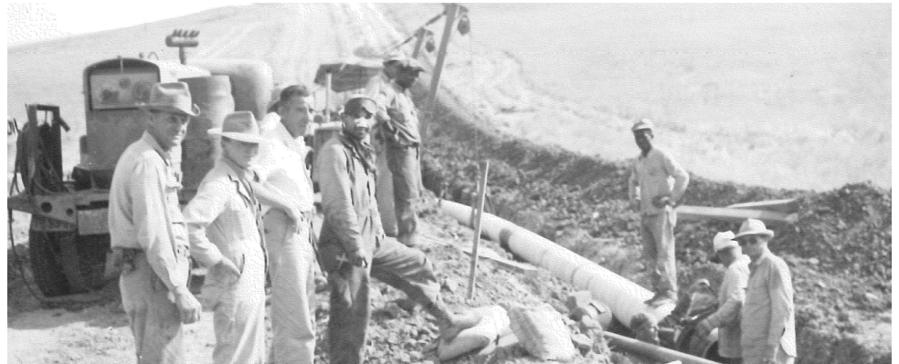
Cuadrillas de SDG&E trabajando en la instalación de la tubería de la Línea 1600 en 1949.
