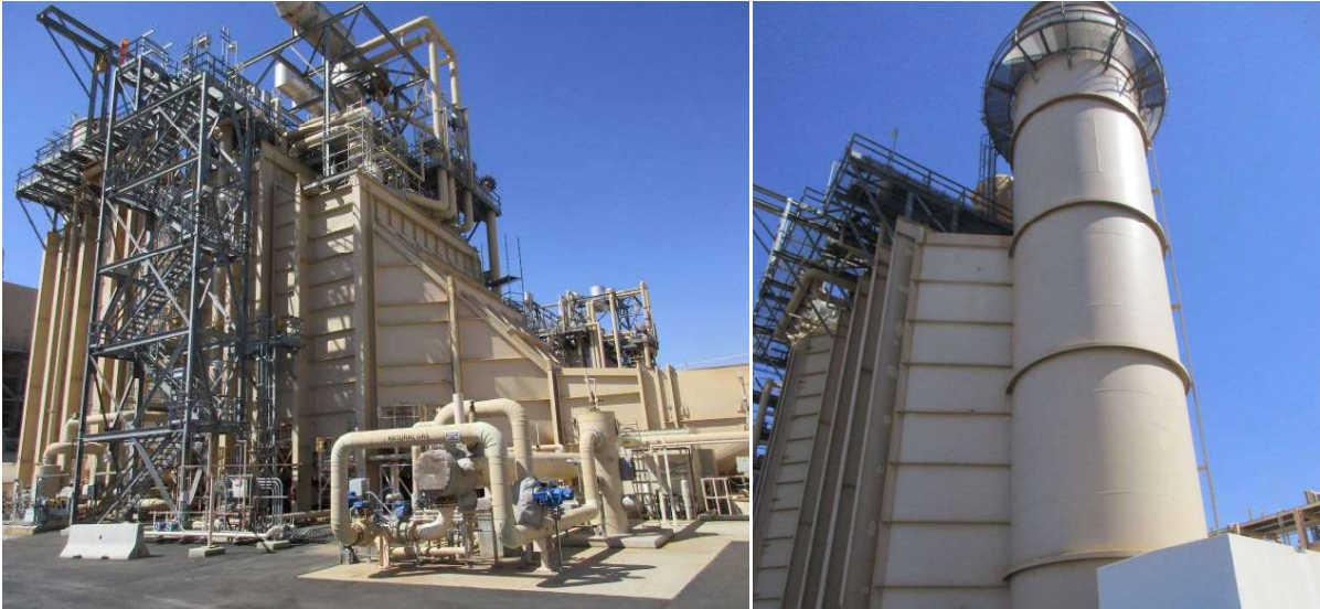
Figure 2-2 — Desert Star Unit 2 HRSG
